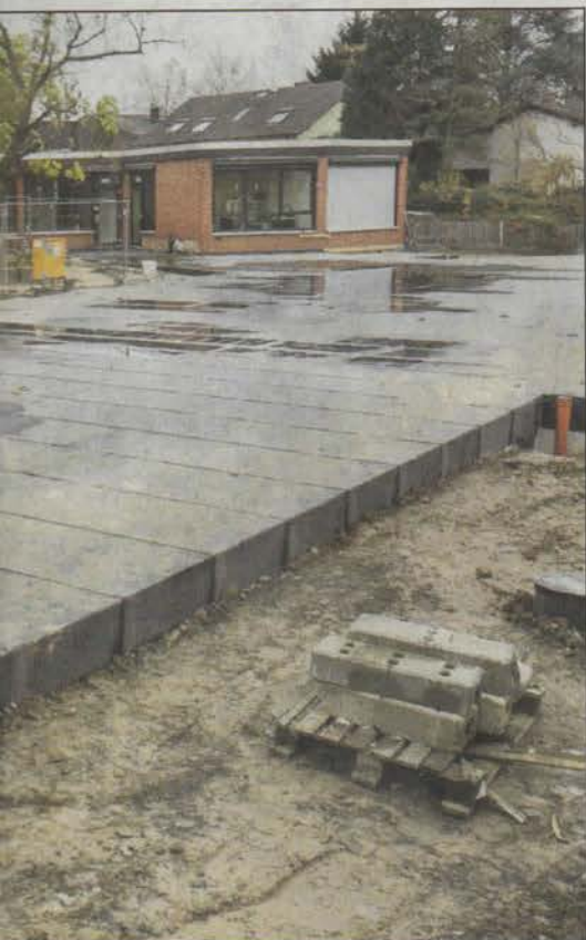
werden die Ständerwände angeliefert und auf der montiert. Bis zum Sommer soll der Anbau an die gestellt sein. ■ Fotos: Häsler
